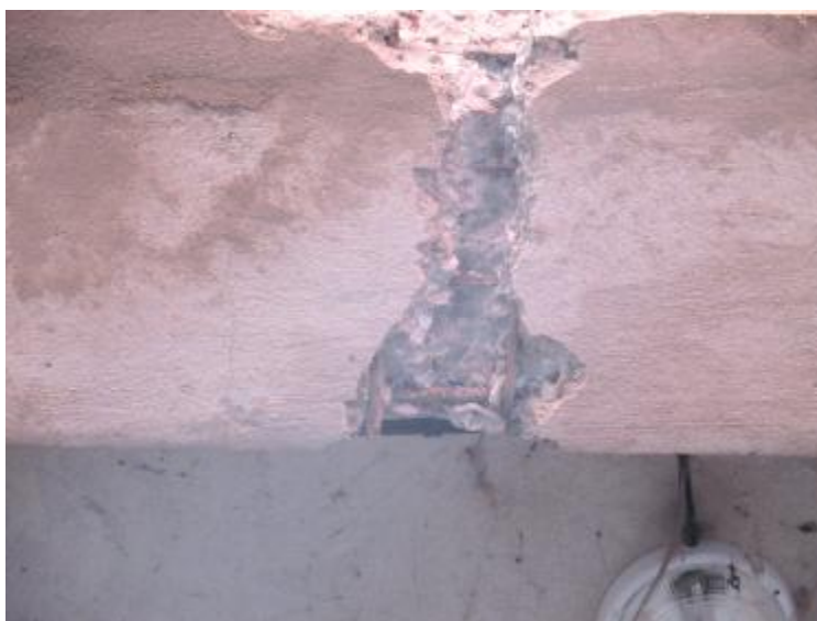
Sonda k ověření výztuže
