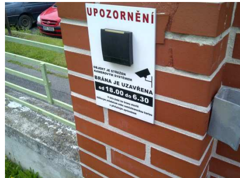
Foto 8 – přístupový systém u vjezdu
