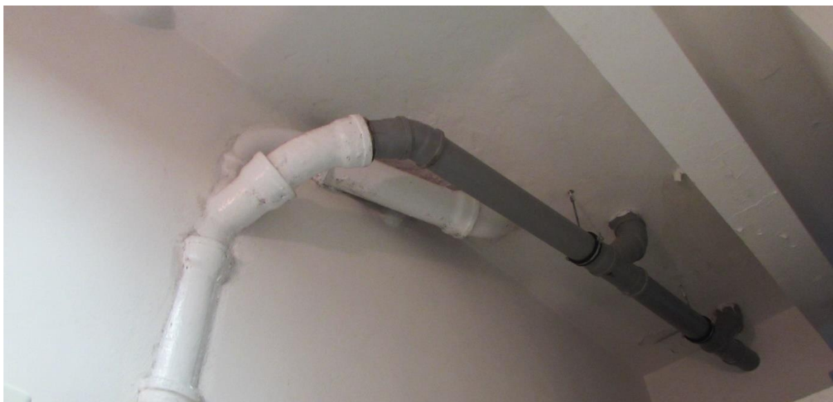
Fotografie 6 – přípojně potrubí do stoupacího potrubí S2
