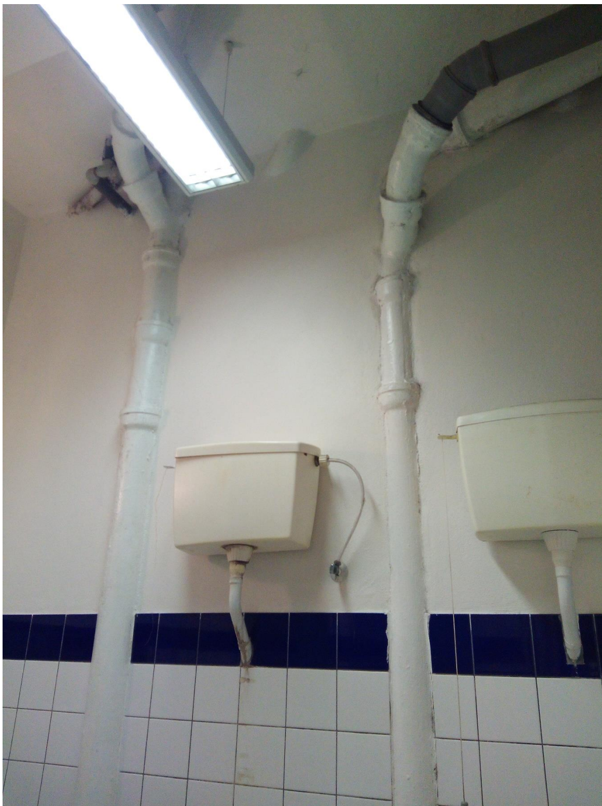
Fotografie 5 – stoupací potrubí S1 a S2 v prostoru pánských sprch
