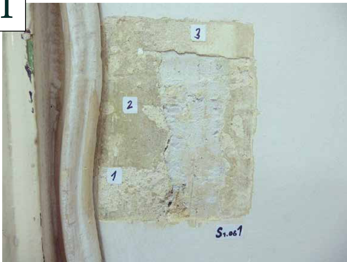
Sondáž stropu - sádrový reliéf s izolační zežloutlou vrstvou na povrchu. cementové opravy.
