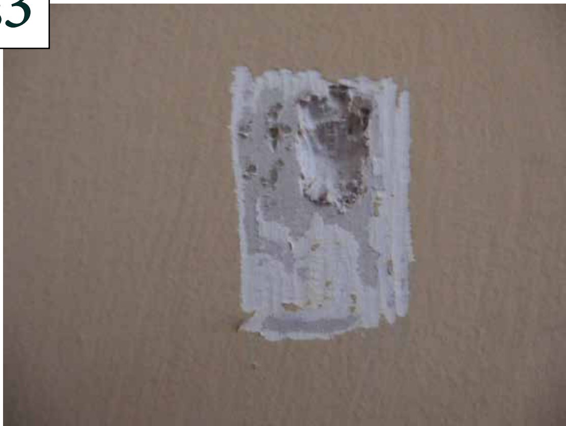
Původní dveřní otvor zakrytý pomocí na perlinku omítnutou sádrokartonovou deskou. Pod deskou jsou z druhé strany ponechány prosklené dvěře- místnost 0.24.
