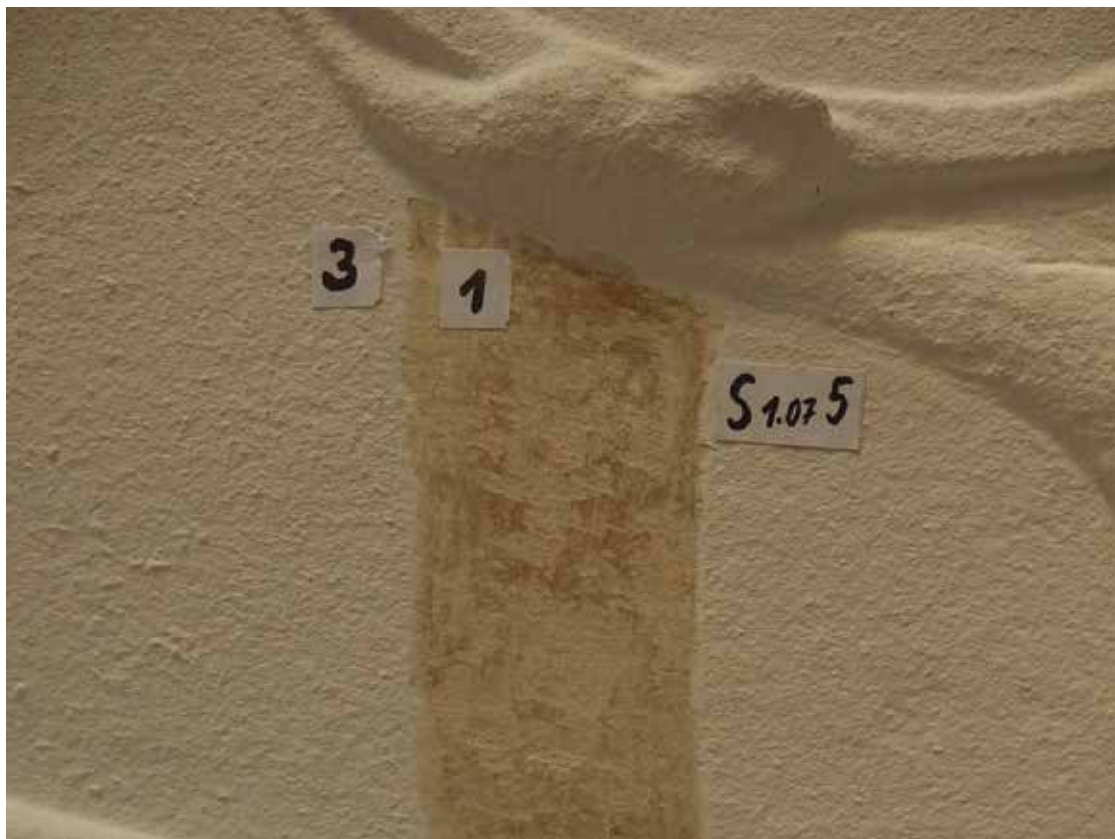
Sondáž stropu - sádrový reliéf s izolační zežloutlou vrstvou na povrchu.
