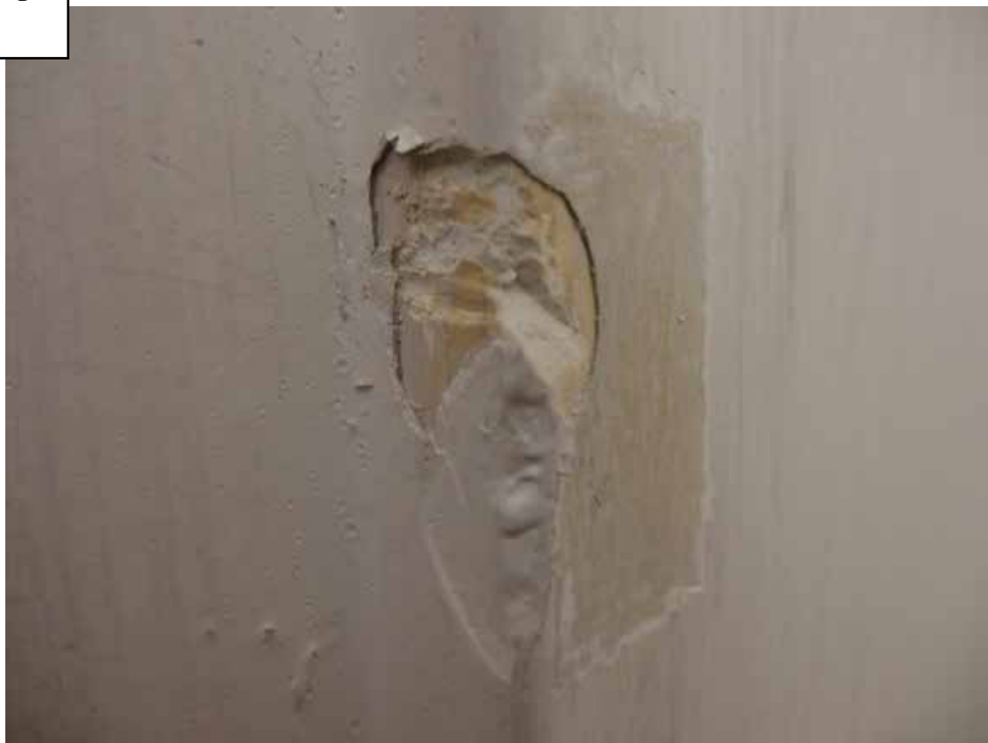
Hlinkový žlutavý nátěr uzavřený pod neprodyšným nátěrem emailového charakteru
