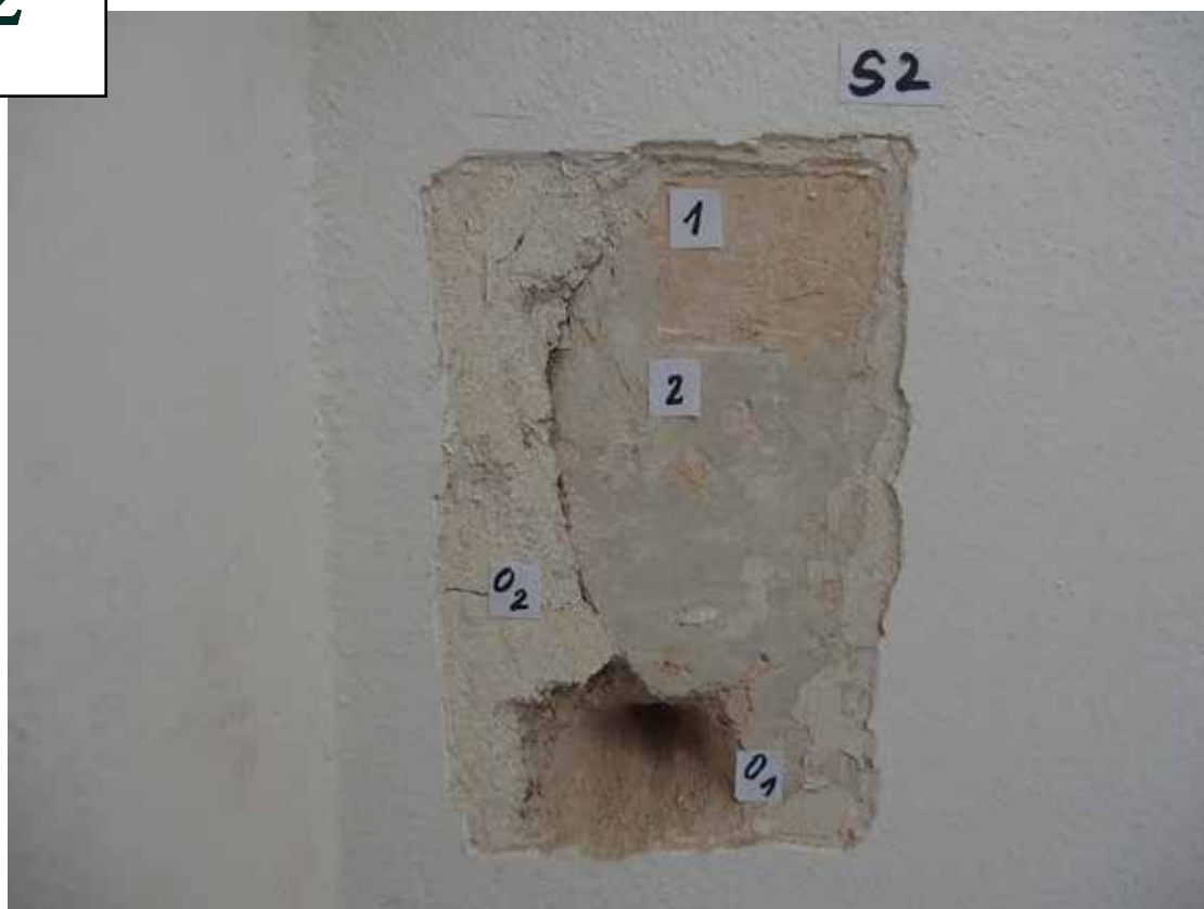
Novodobá vápenná malta spolu s fragmenty starších omítek - monochromní světlé nátěry
