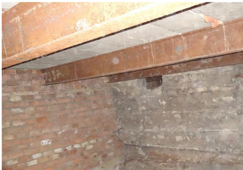
Železobetonová stropní konstrukce nad mezipatrem (podlaha 2. NP).
