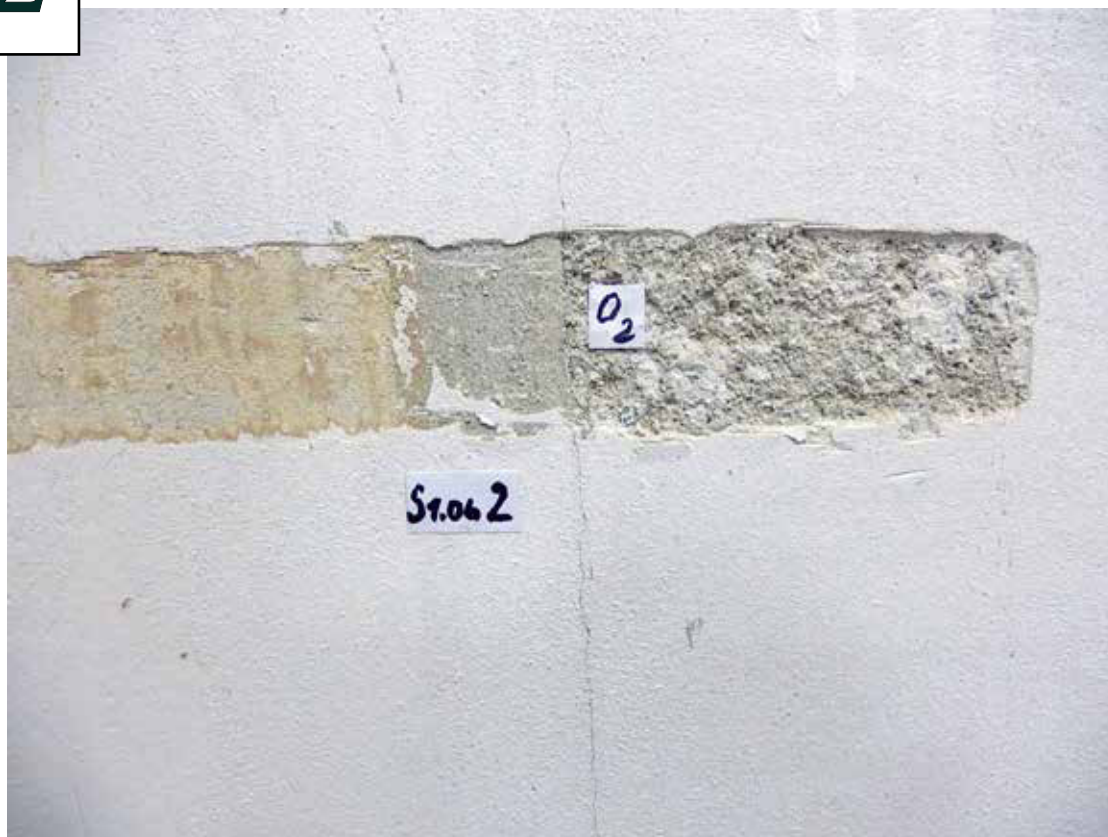
Cementová zazdívka původního dveřního otvoru
