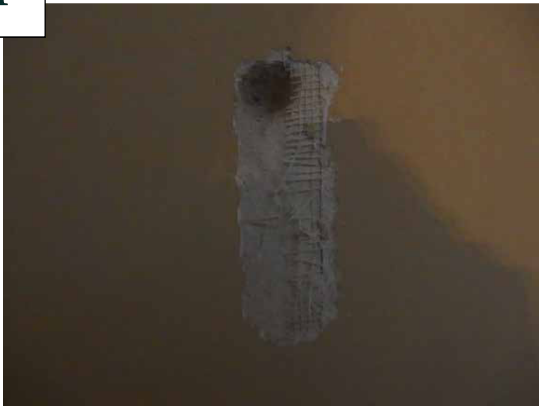
Původní dveřní otvor zakrytý pomocí na perlinku omítnutou sádrokartonovou deskou. Pod deskou lze předpokládat přítomnost dnes zakrytých prosklených dvěří. viz místnost č. 0.30
