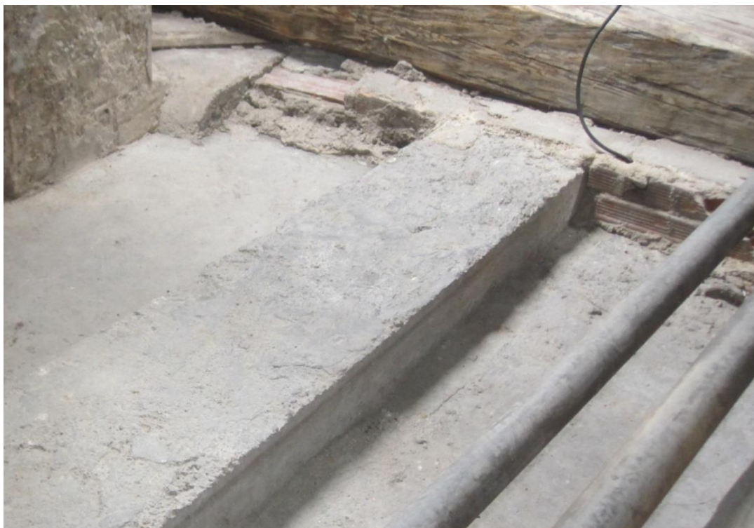
Železobetonová podlaha v severozápadní části podkroví nad jižním křídlem
