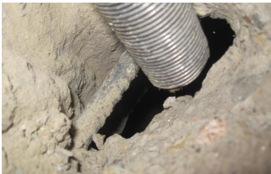
Železobetonová konstrukce v podkroví, detail s ocelovou výztuží, sonda
