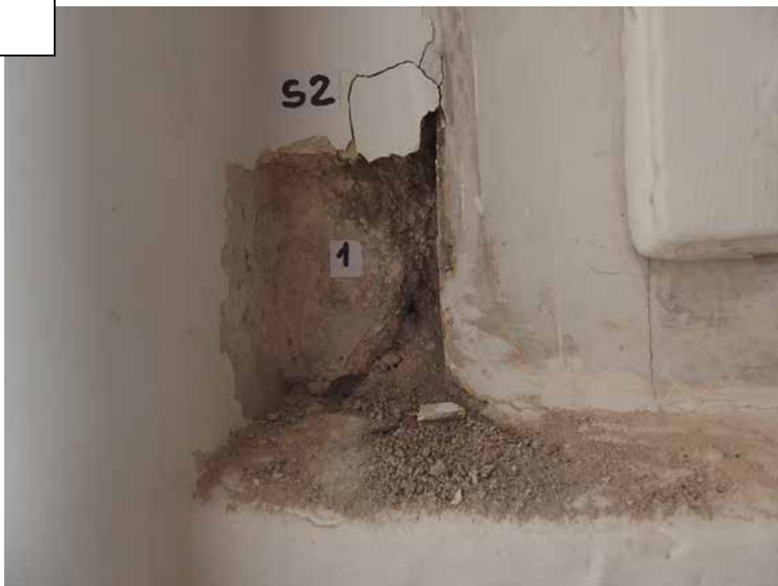
Původní návaznost omítek na dřevěné okenní rámy - monochromní světlé vápenné nátěry
