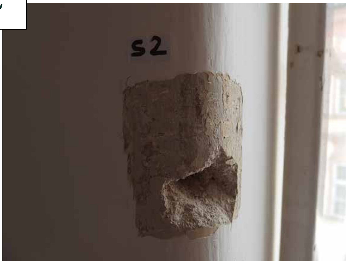
Zaoblení hrany okenní špalety- novodobé vápenné malty
