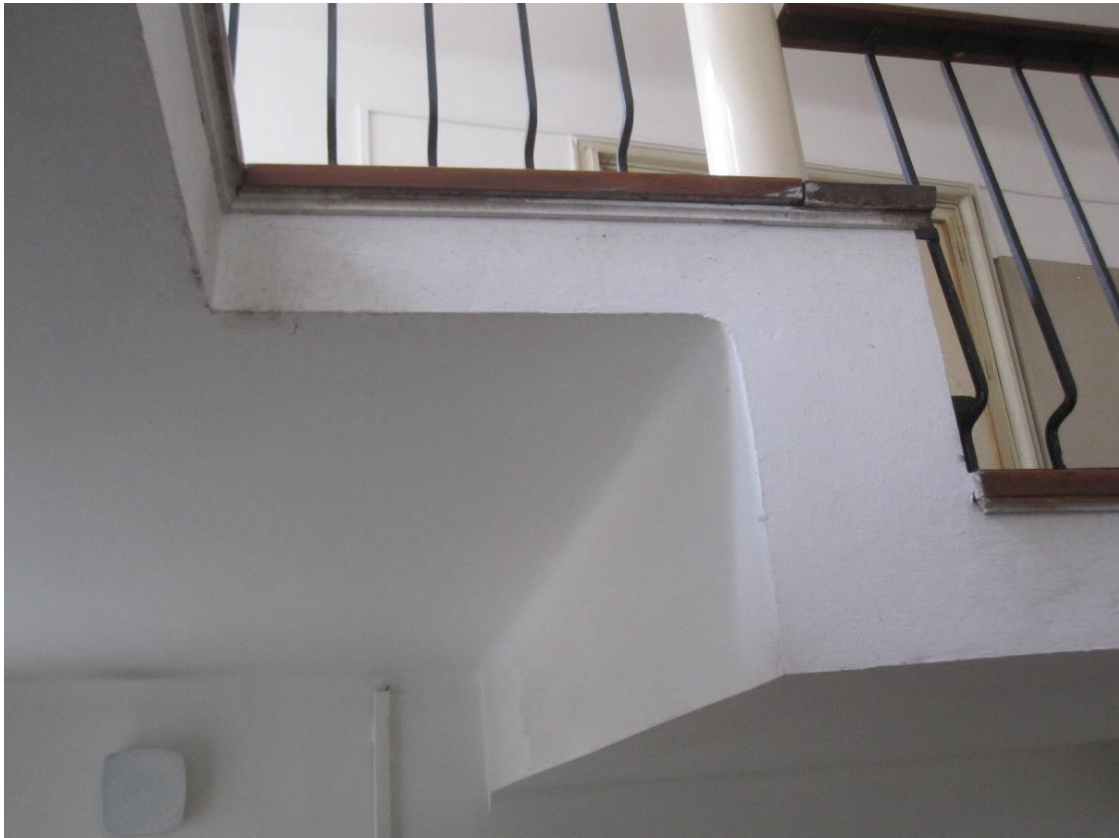
Vykonzolovaná železobetonová deska s průvlakem ve 3. NP
