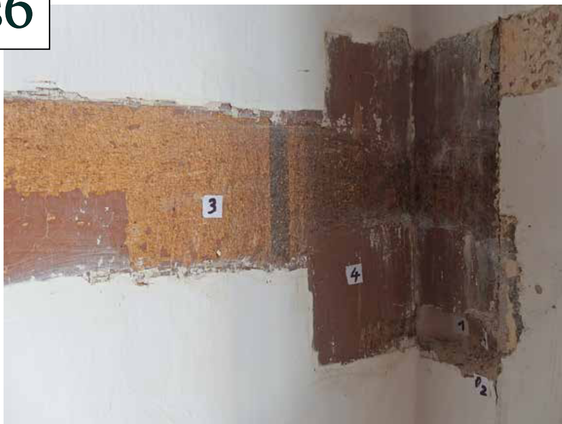
fragmenty okrové výmalby s lineárním rámováním pokryté degradovanou fermežovou izolační vrstvou- č. 3 ,emailový hnědý nátěr - č. 4
