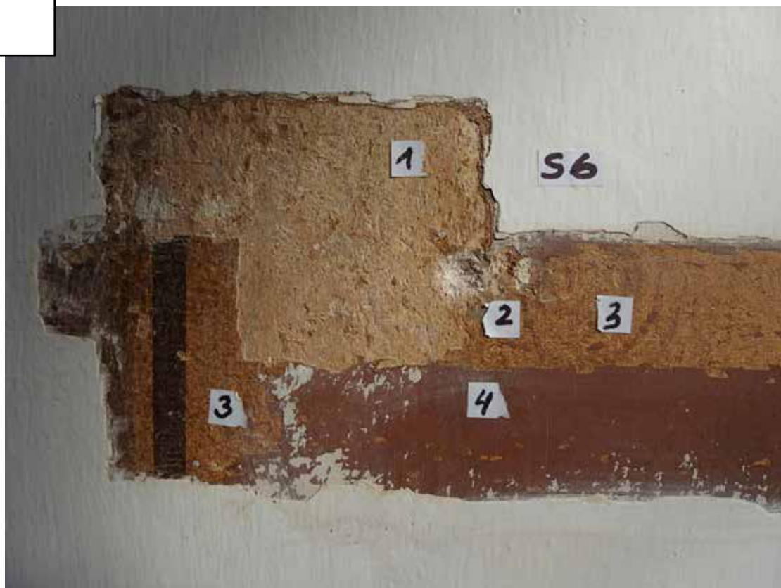
fragmenty okrové výmalby s lineárním rámováním pokryté degradovanou izolační vrstvou- č. 3 emailový hnědý nátěr - č. 4
