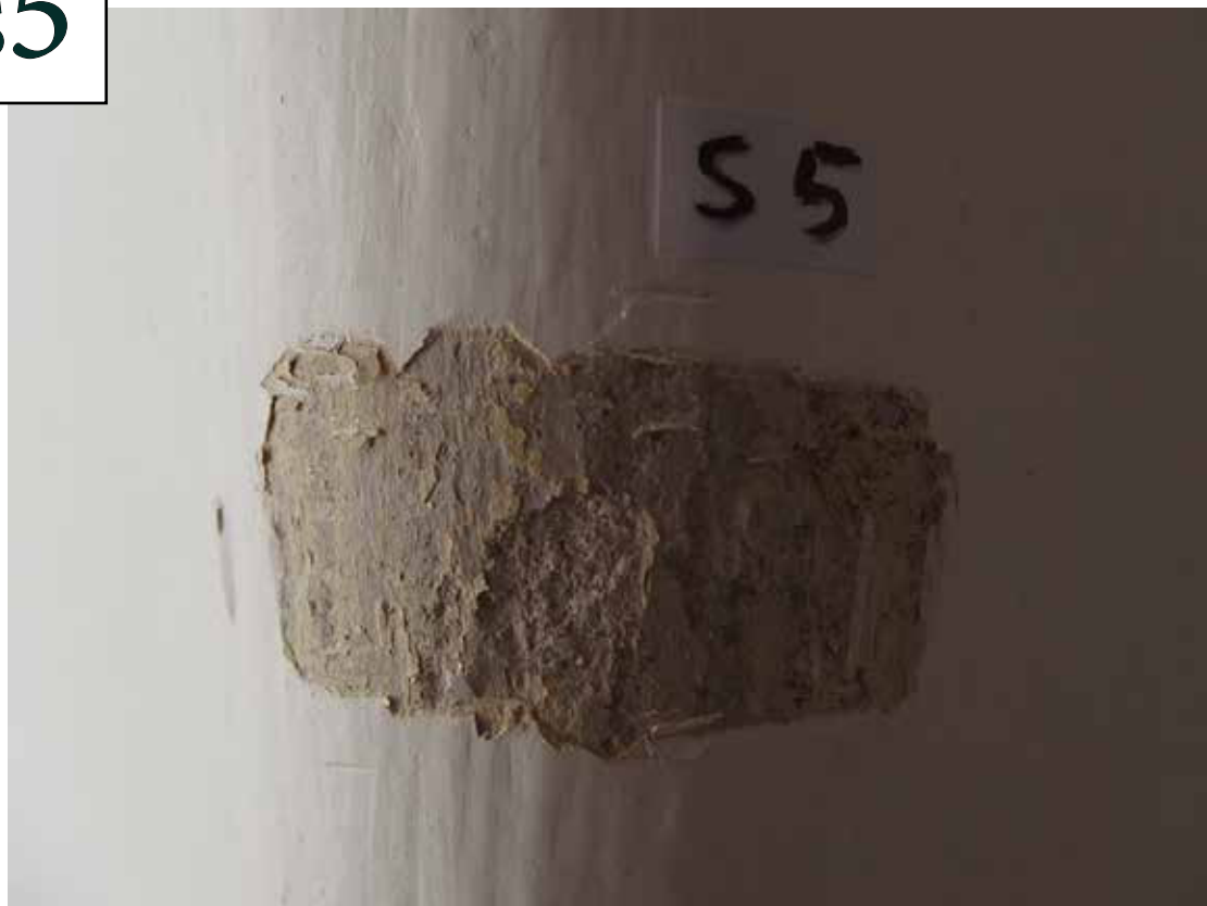
Zaoblení hrany okenní špalety- novodobé vápenné malty
