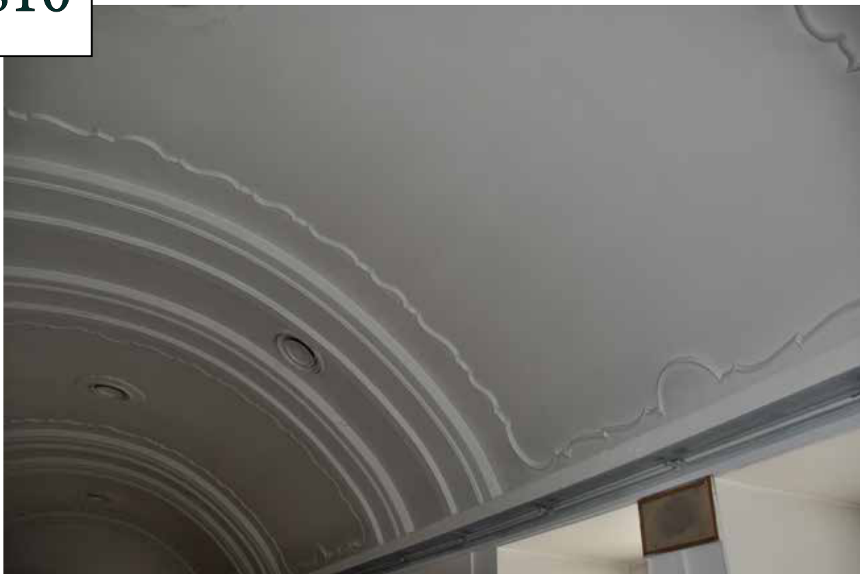
Klenba místnosti tvořená pomocí sádrových ploch a sádrové modelace zdobného reliéfu
