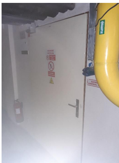
Požární dveře do plynové kotelny
