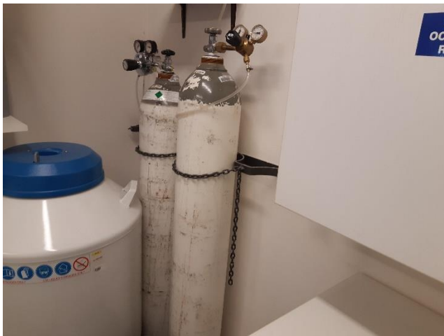
U Nemocnice 4 – Uložení tlakových lahví
