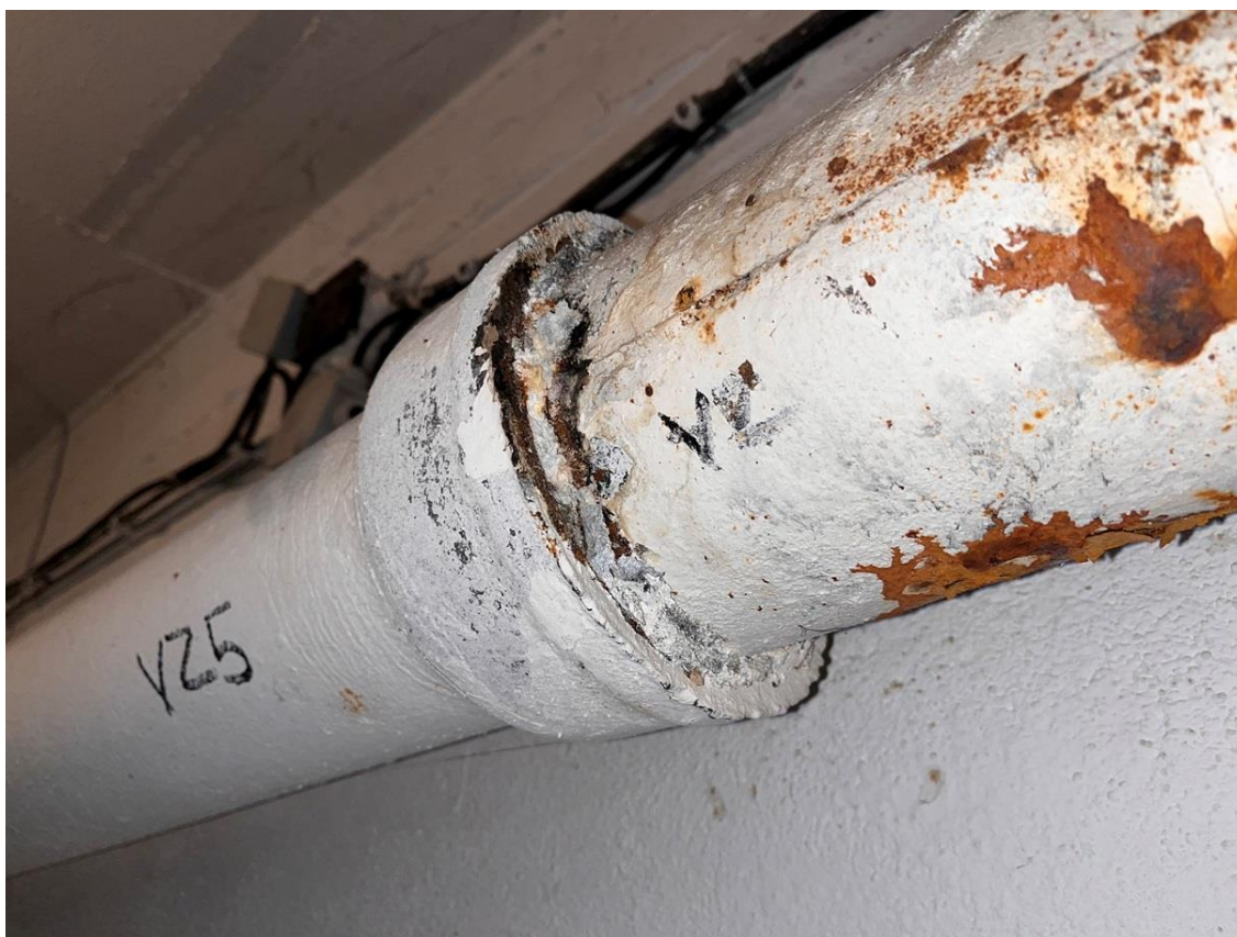
Foto 009 – odběr vzorku VZ5, těsnění kanalizačního potrubí v 1.PP – AZBEST NEPOTVRZEN
