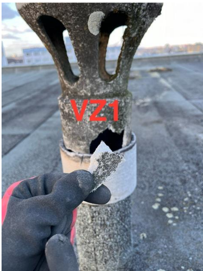
Foto 001 – odběr vzorku VZ1, odvětrání kanalizace na střeše – POTVRZEN AZBEST
