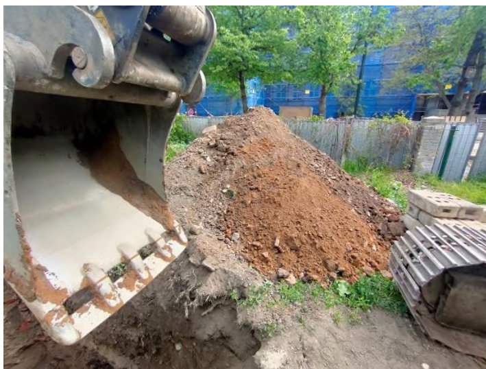
Obrázek 2: Výkopek kopané sondy KS1; patrný rozdíl mezi materiálem vzorku SM1 (navážka) a SM2 (písčitý sediment fluvialního charakteru)
