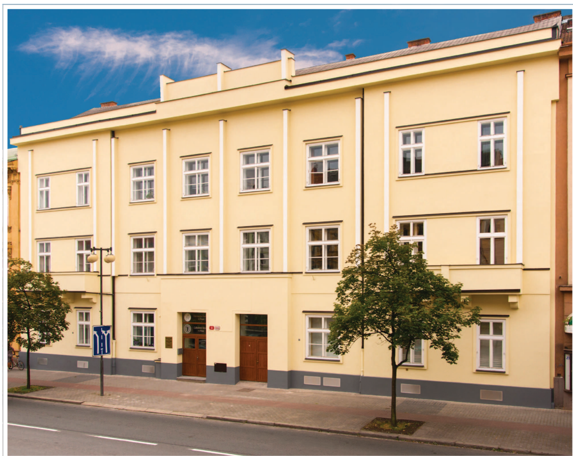
Budova děkanátu, Husova 3, Plzeň.
