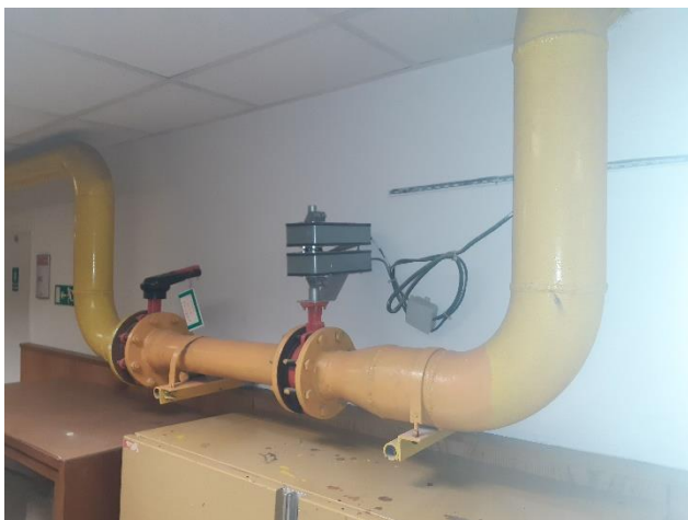
Albertov 6 – automatický uzávěr přívodu ZP
