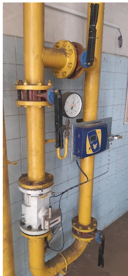
detekce plynů v kotelnách a automatické uzavření plynu
