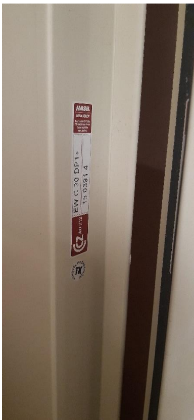
pož. dveře po rekonstrukcích
