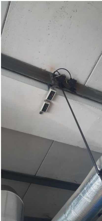
detekce plynů v kotelnách a automatické uzavření plynu
