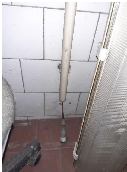
Studničkova 4 - Záplavové čidlo kotelna
