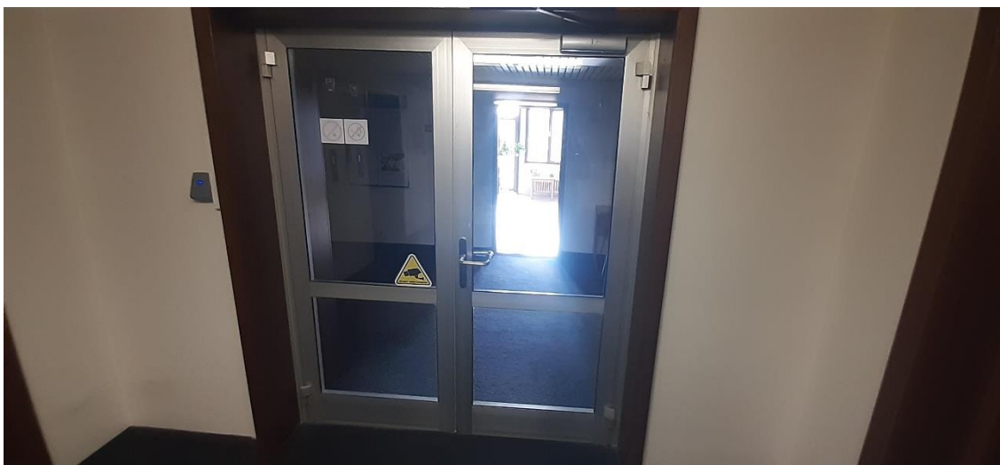
požární dveře oddělující podlaží
