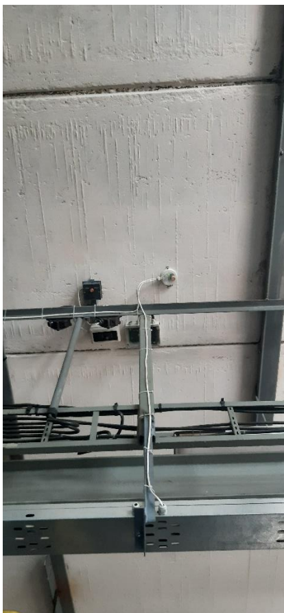
detekce plynů v kotelnách a automatické uzavření plynu
