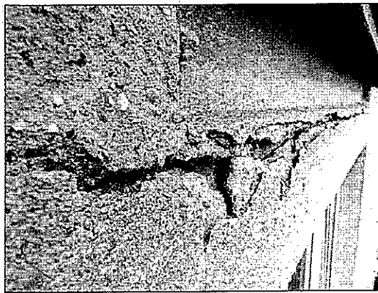
č. 20 Detail poškození římsy, pavilon B
